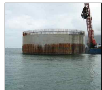
교량 우물통 공사
